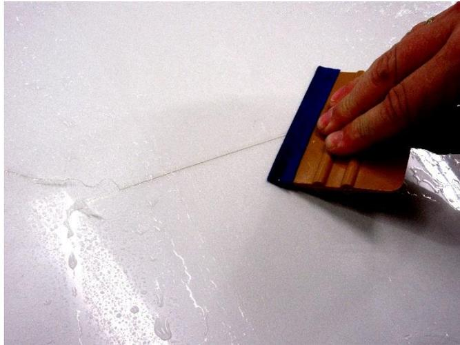
Um eventuelle Lufteinschlüsse zu entfernen, drücken Sie die Folie noch einmal auf der Schnittlinie mit dem Finger an.
