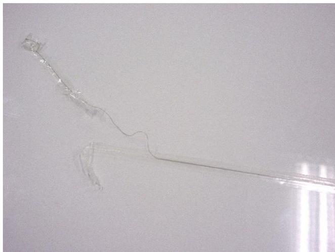
Führen Sie jetzt die Nassverklebung der Folie durch. Positionieren Sie die Folie und rakeln Sie sie mit Druck über das Knifeless Tape an, ohne die vorbereiteten überstehenden Enden des Knifeless Tapes zu überdecken.
