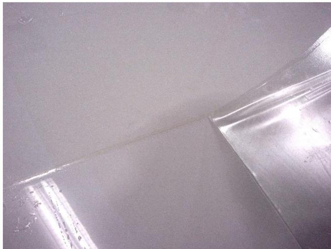
Entfernen Sie dann das Trägerband unter der Folie und befeuchten Sie dabei gleichzeitig den Untergrund an der Folienkante.
