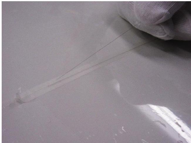
Ziehen Sie den Faden zum Schneiden mit gleichmäßiger Geschwindigkeit in flachem Winkel weiter.
